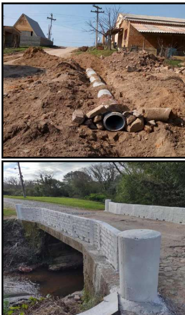
Figura 116 – Sistema de drenagem urbana do município: obra de canalização
