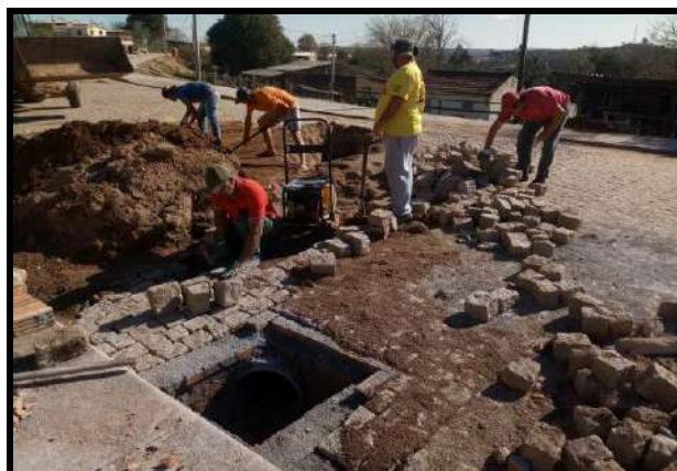
Figura 118 – Instalação de bueiros
